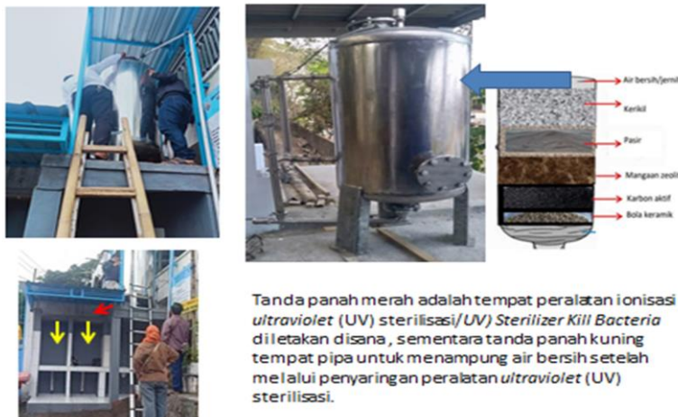
Gambar 2. Bak tabung diberi material-material penyaring dan dinaik-an ke atas
